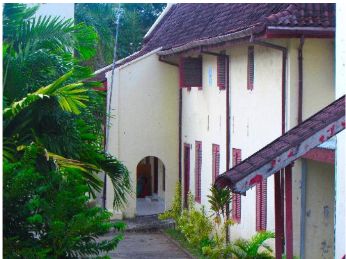
Bangunan F, tahun 1920 dan tahun 2021 (sumber: digitalcollections.universiteitleiden.nl, dan BPCB Prov.Sul-Sel)
