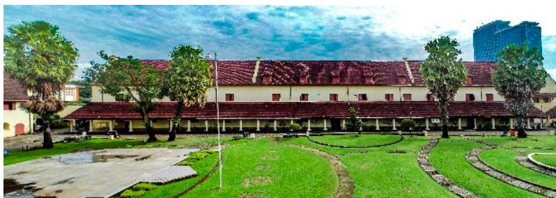
Bangunan M tahun 1920, tahun 1970-an dan tahun 2021 (sumber: digitalcollections.universiteitleiden.nl , dan BPCB Prov.Sul-Sel)
