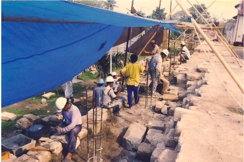
Pemugaran dinding sisi barat Fort Rotterdam (sumber: BPCB Prov. Sul-Sel)
