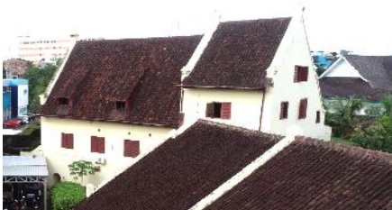
Bangunan H, tahun 2021 (sumber: BPCB Prov.Sul-Sel)
